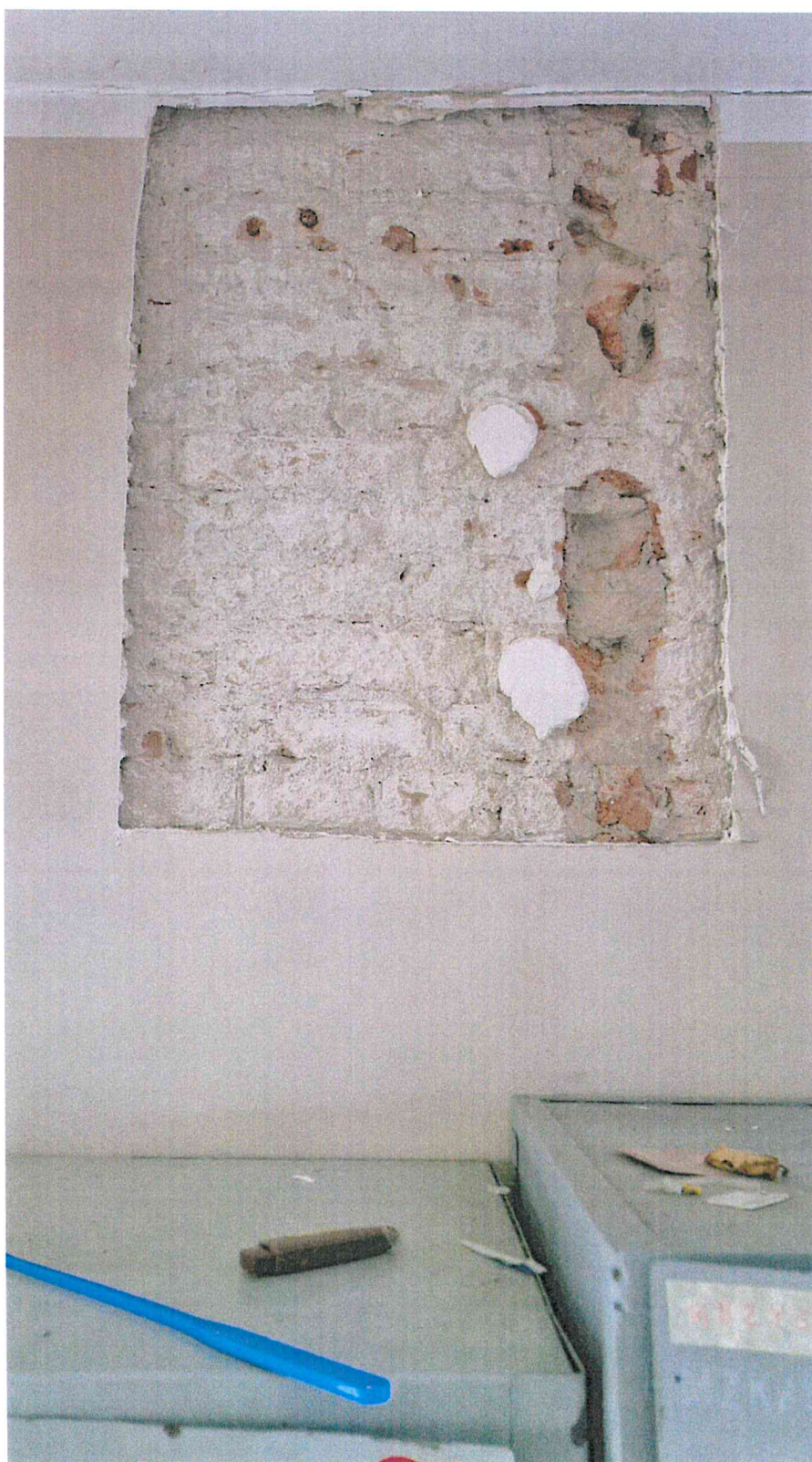
Odkrywki ścian w części portierni – brak charakterystycznych spękań.
