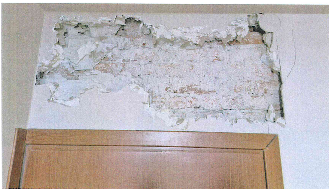
Odkrywki ścian w części portierni – brak charakterystycznych spękań.
